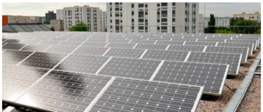
350m 2 de panneaux photovoltaïques aménagés sur la toiture de la chaufferie
